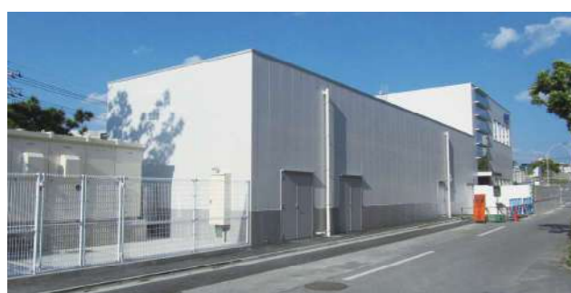
再生医療研究センター外観
