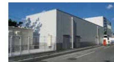
再生医療研究センター外観
