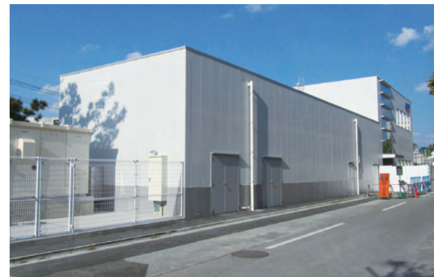
再生医療研究センター外観
