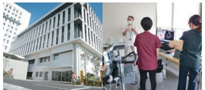
管理棟 シミュレーションセンター
